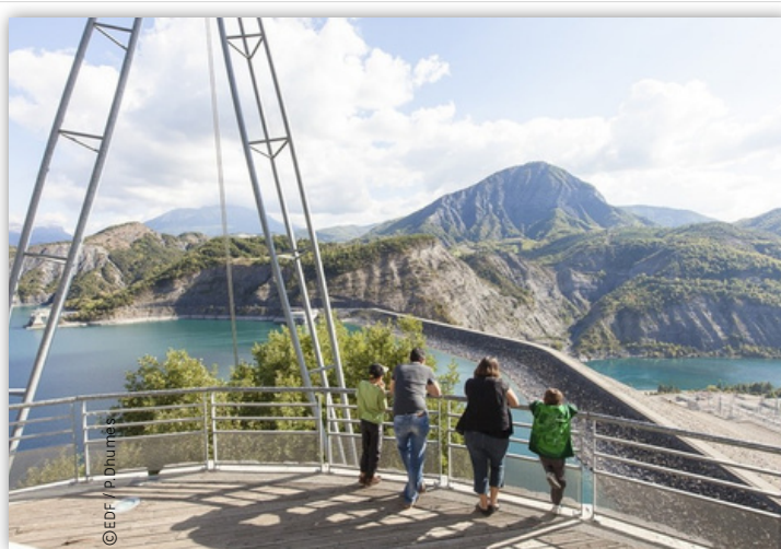
EDF - Centrale de Serre-Ponçon ©CAPA Pictures - Christophe Bruno
