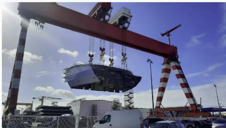
Portique et bloc de paquebot aux Chantiers de l'Atlantique à Saint-Nazaire © Radio France - Héliène Roussel
